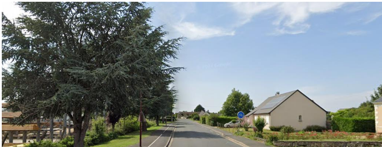
Photo 5. Aménagement cyclable sur la rue principale – Source : auddicé
