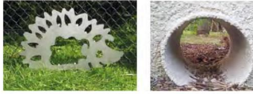
Aménagements d'ouvertures en pied de clôture (avec hérisson décoratif) et de muret
